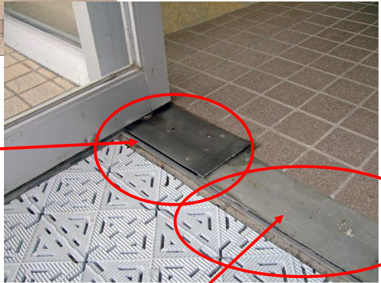
モルタル部破損により塗りなおした部分
